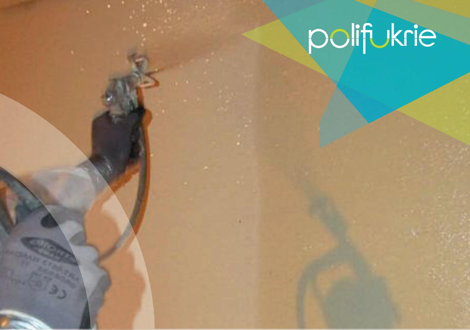
POLIFUKRIE wird im Spritzverfahren bei ca. 30°C Materialtemperatur verarbeitet und ist lösungsmittelfrei. POLIFUKRIE wird mit einer geeigneten 2K-Spritzanlage einschichtig, bei Bedarf auch mehrlagig, bis zur erforderlichen Schichtdicke appliziert. Aufgrund seiner strukturelastischen Eigenschaften ist die ausgehärtete Beschichtung hoch chemikalienbeständig, extrem abriebfest und dennoch rissüberbrückend.
