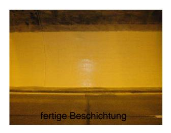
Die POLIFUKRIE Spritzbeschichtung ist im System verwendbar (Spachtel bzw. Haftgrund) kann jedoch auch auf unbehandelten Betonoberflächen appliziert werden.
