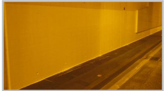
**POLIFUKRIE ist eine 2-K, rissüberbrückende Spritzbeschichtung für Beton- und Stahlelemente.**
