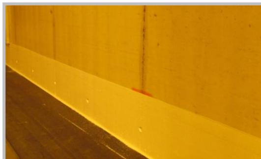
**POLIFUKRIE wird im Spritzverfahren bei ca. 30 Grad Materialtemperatur verarbeitet und ist lösungsmittelfrei.**
